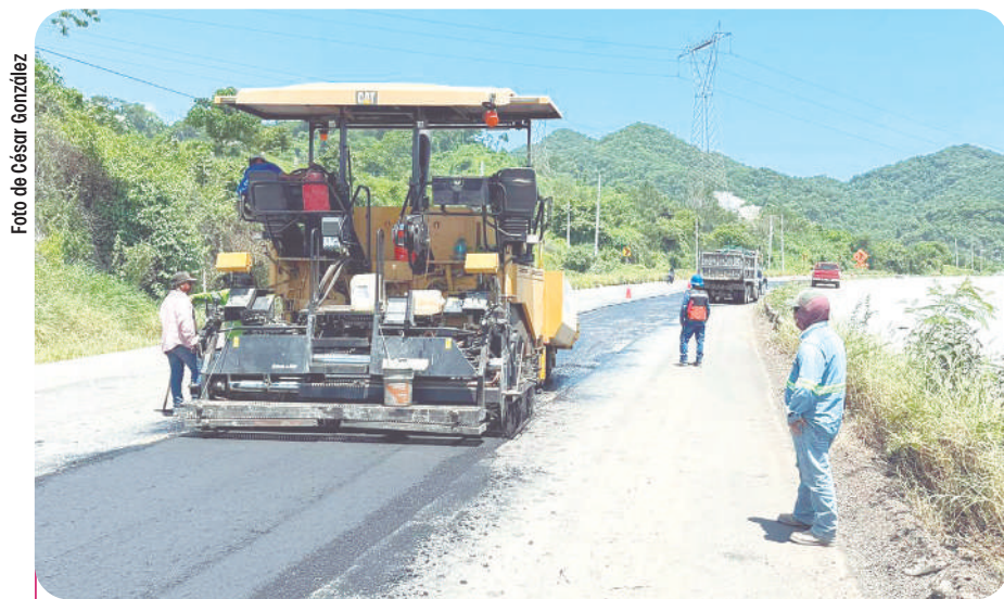
Los trabajos están a cargo de la SICT.
