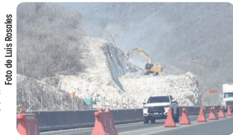
Foto de Luis Rosales Autoridades realizaron inspecciones en La Salada tras detonaciones por ampliación de la autopista
