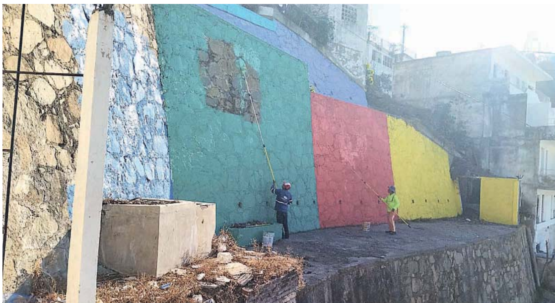
La brigada de embellecimiento urbano continúa con los trabajos de renovación de pintura y mejoramiento de espacios públicos del Sector 4 en el Centro Histórico de Manzanillo.
