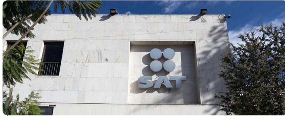
Oficinas del Servicio de Administración Tributaria en la Ciudad de México.
