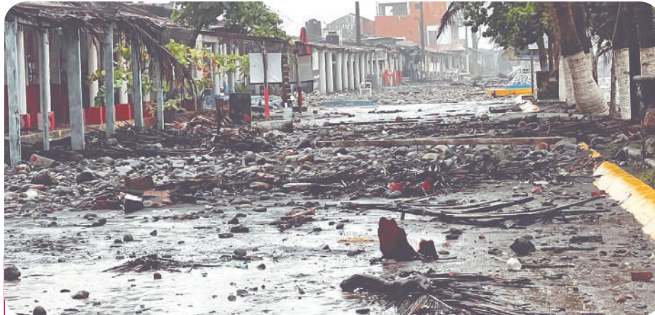
En Armería, las fuertes marejadas arrojaron piedras y escombros que obstruyeron la parte poniente del camino de El Paraíso.
