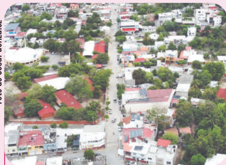
Se mejoró la vialidad con concreto hidráulico.
