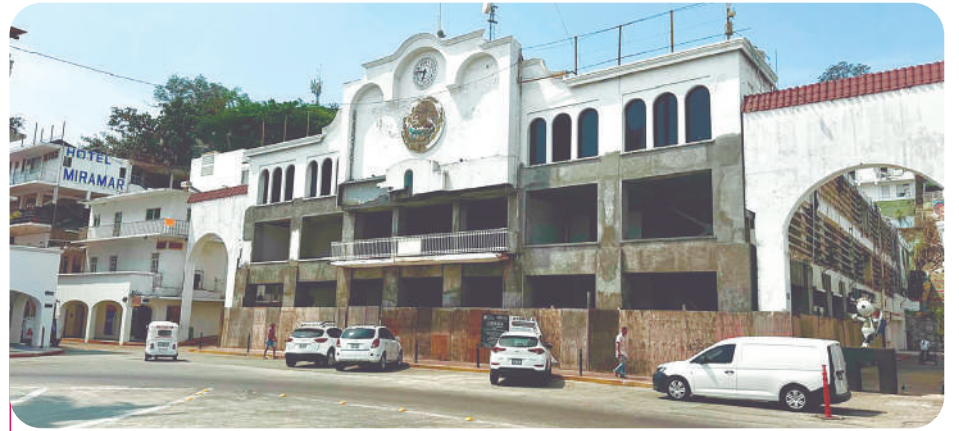
Tanto los estudios y trabajos estuvieron mal hechos.
