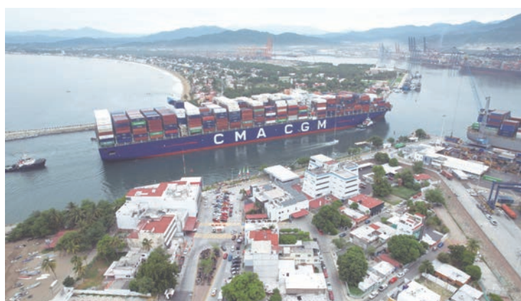
Con trabajos recientes de dragado, Manzanillo puede recibir buques de hasta 400 metros de eslora.
