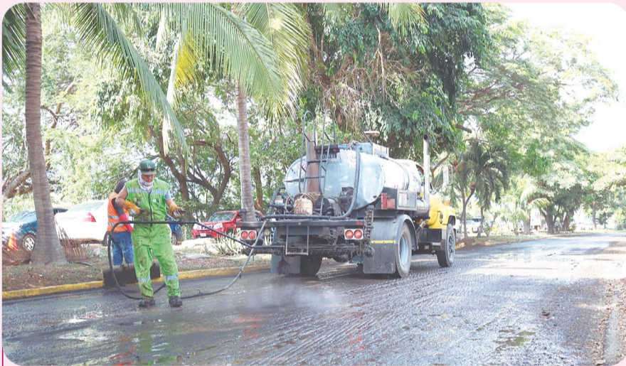
En la rehabilitación de la avenida Manzanillo se invierten más de 7 millones de pesos.
