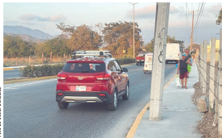
En la construcción de una primera etapa de 918.57 metros cuadrados de banquetas se invirtieron 1.3 millones de pesos.
