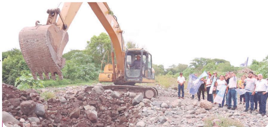
El alcalde Riult Rivera encabezó el arranque de la obra, la cual, dijo, beneficiará directamente a los habitantes de las colonias cercanas al arroyo.
