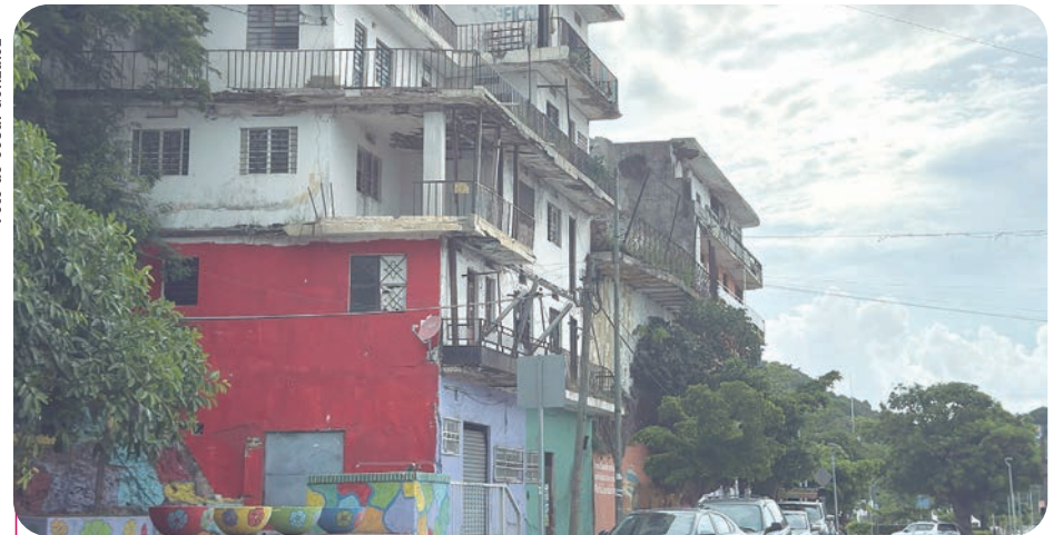
Edificio ubicado en prolongación de la calle Juárez, frente al malecón del Paseo del Espíritu Santo, en el centro de la ciudad.
