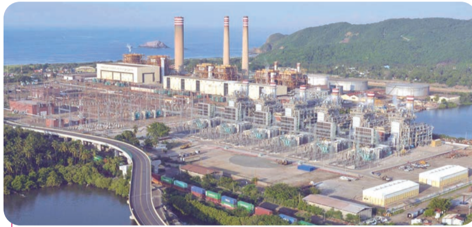
Para llevar a cabo este proyecto, se llevaron 12 meses de preparación y 21 meses de construcción de la planta.
