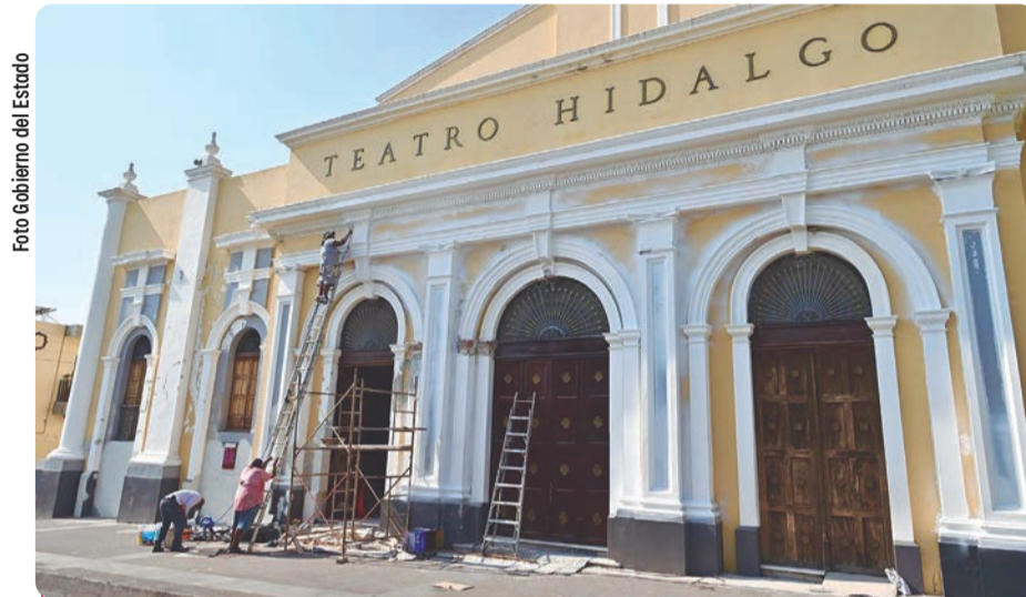
Los trabajos se concentran actualmente en la intervención de la fachada principal del edificio.
