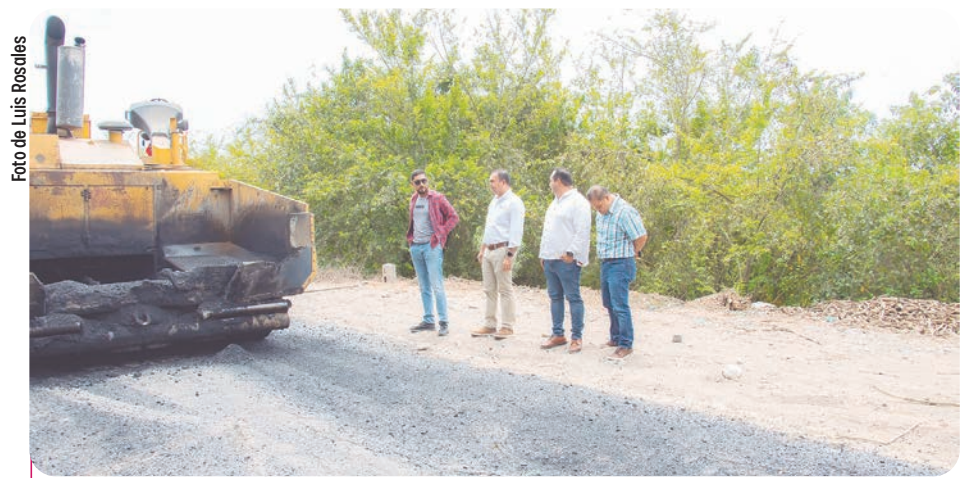
El presidente municipal realizó un recorrido para supervisar los trabajos.
