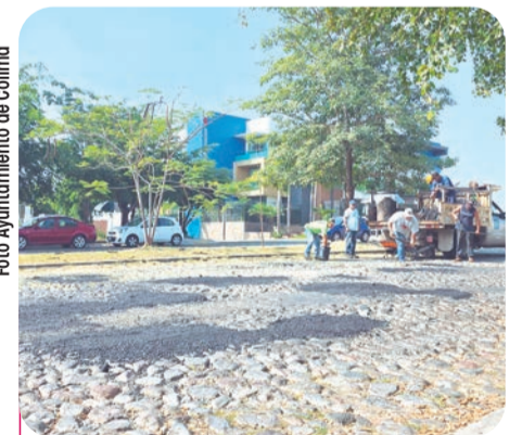
El Ayuntamiento de Colima informó que estos trabajos los realizan en asfalto y empedrado.
