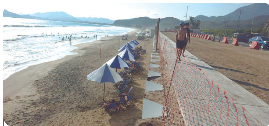
La obra del nuevo malecón de Miramar registra más de 60 por ciento de avance en su primera etapa de construcción.
