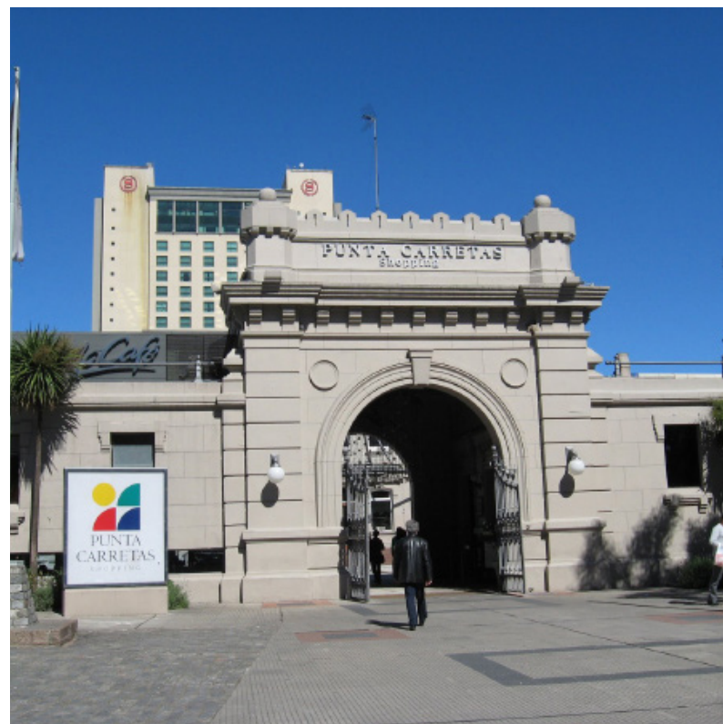
De cárcel a centro comercial. Al fondo, el hotel Sheraton.
