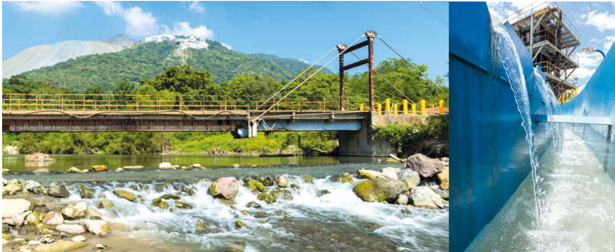
De forma constante se realizan monitoreos del río Minatitlán y predios aledaños a la Planta de Beneficio para garantizar la calidad del agua.
